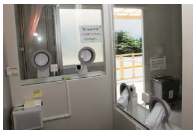
↑職員側から撮影 接することなく手を差し入れ 抗体採取できるように作られています
