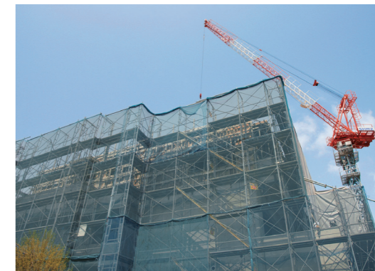
急ピッチで工事が進む現場
