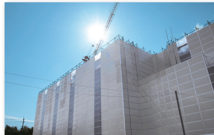
高いクレーン近くまで建ち上がった春風の外観
