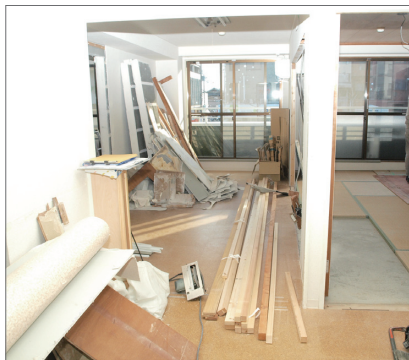
急ピッチで進む改築工事
