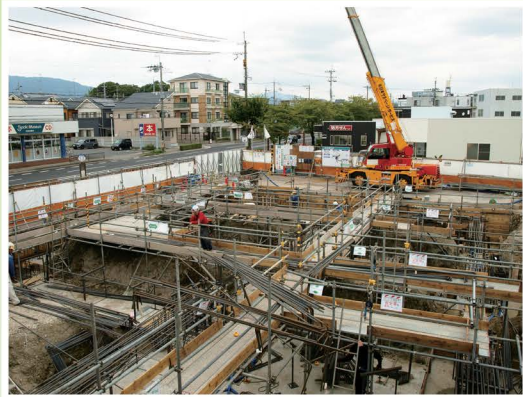
基礎工事が進む現場
