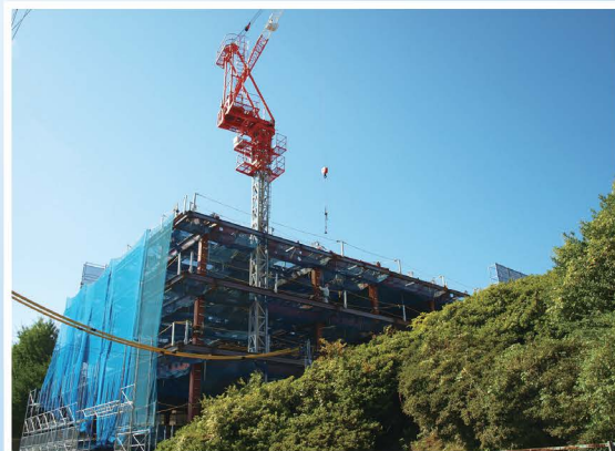
緑の中、着々と進む建設工事
