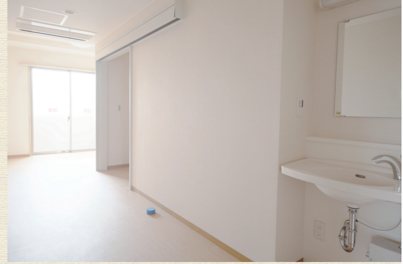
完成間近のショートステイ居室
