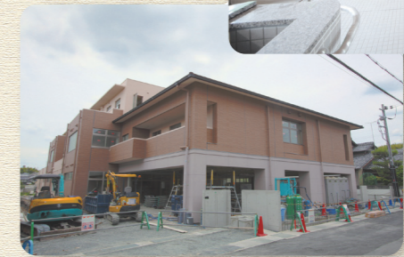
急ピッチで最終工事が進む「介護複合施設 東向日」
