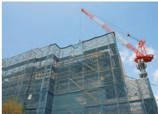
急ピッチで工事が進む現場
